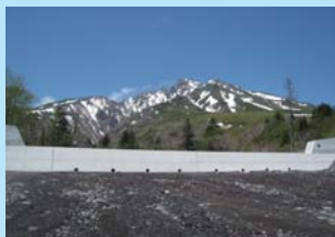
写真：過去の工事で完成した治山ダム
