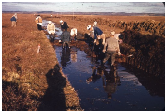
図1. 1961年秋に始まった排水溝掘削。
