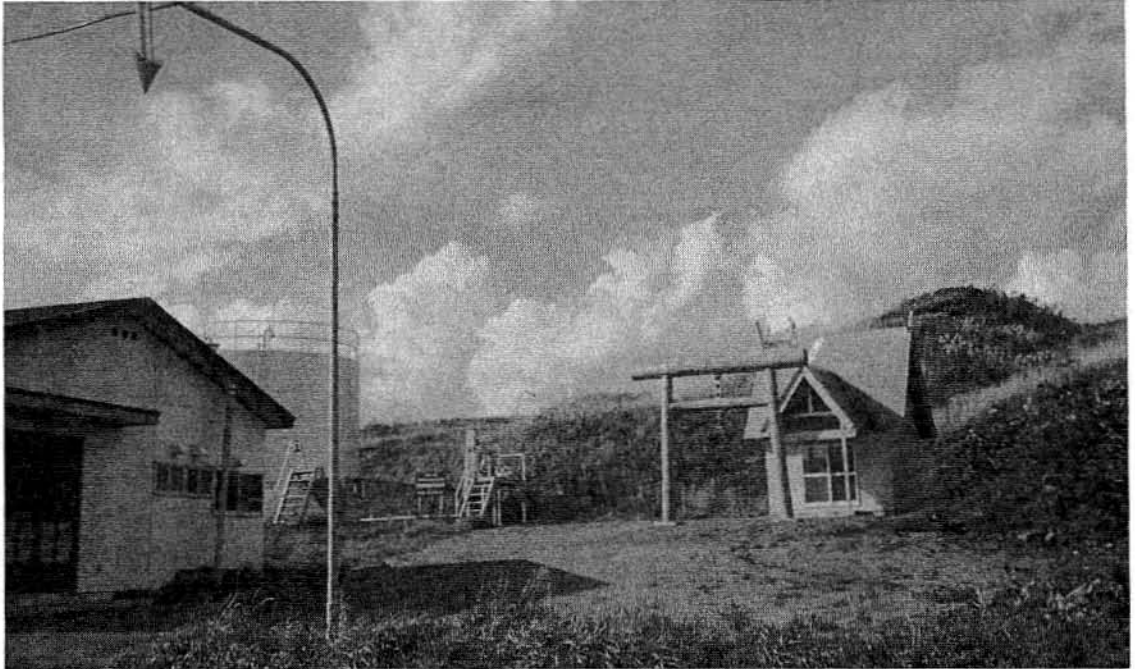
平成2年新建立された「政治港神社」左は政治自治会館、その向うに給油施設タンクが見える。
