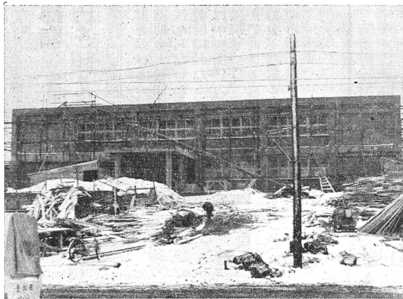
工事中の役場庁舎
