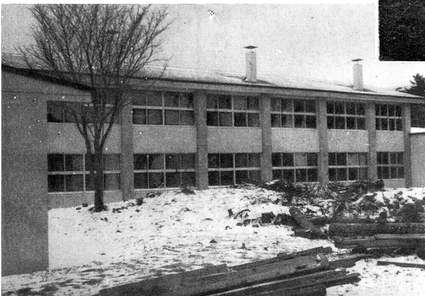
第一期工事が終った沓形小学校々舎 ↓
