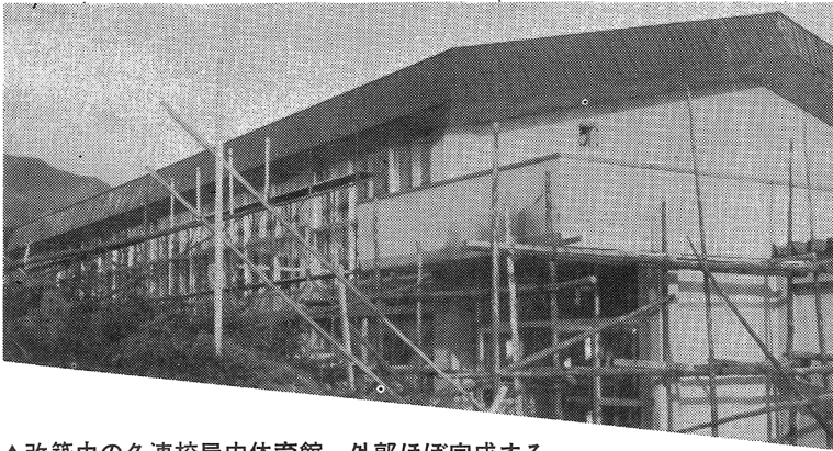
▲改築中の久連校屋内体育館，外郭ほぼ完成する
