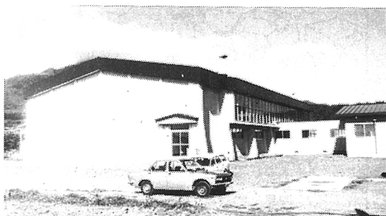
仙中屋内体育館 53年9月竣工 鉄骨造，面積 635㎡
