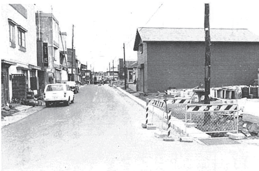
市外2条通特殊改良工事 延長422m \phi 300トラフ 54.11.30完成
