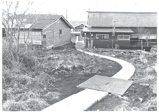
沓小グランド排水側溝改修工事 延長87m 54.7.30完成
