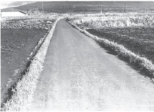
神居糖北浜3線道路舗装工事 延長200m 54.6.25完成
