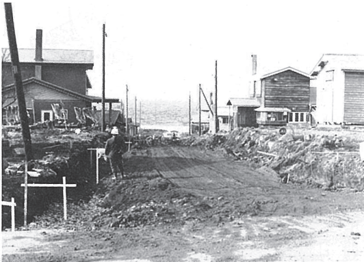
新湊海岸線道路改良工事 延長115.66m 55.1.30完成見込
