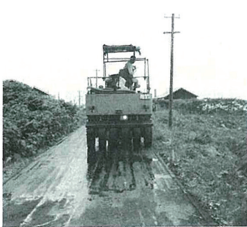
神居糠線舗装
