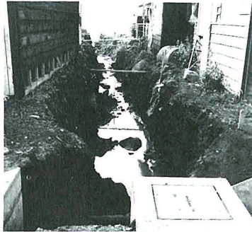
泉町側溝工事
