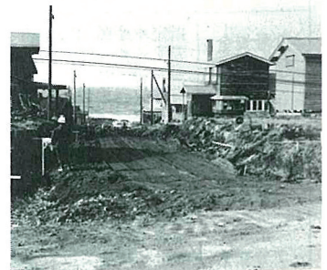
新湊道路工事
