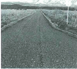
▲ 経営林道蘭泊線開設工事は、工事費1千211万2千円で、690mが完成し、55年度と合せ、1500mが完成しました。
