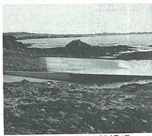
▲新湊第3地区船揚場整備事業
