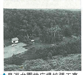
▲見返台園地広場拡張工事
