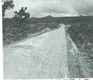
▲経営林道新湊線開設事業
