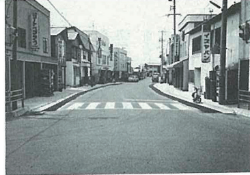
◎市街横潤岬線側溝整備工事 工事費7,620千円 59年6月19日完成
