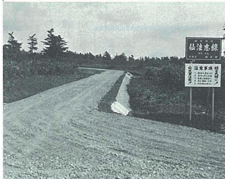
◎経営林道仙法志線開設工事 工事費24,925千円 59年10月3日完成
