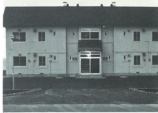
◎利尻町公営住宅(泉ヶ丘団地)1棟4戸 工事費31,600千円 59年10月31日完成
