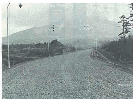
◎日出線道路改良工事(第一工区) 工事費77,500千円 59年11月27日完成
