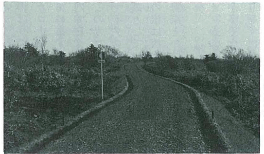
仙法志連絡改良舗装事業
