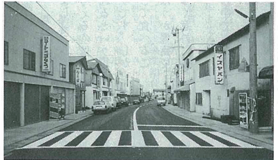
市街横潤舗装側溝整備工事
