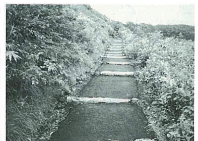
▲見返台公園遊歩道舗工事
