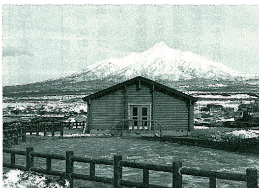
仙法志御崎公園整備事業 61年12月5日完成
