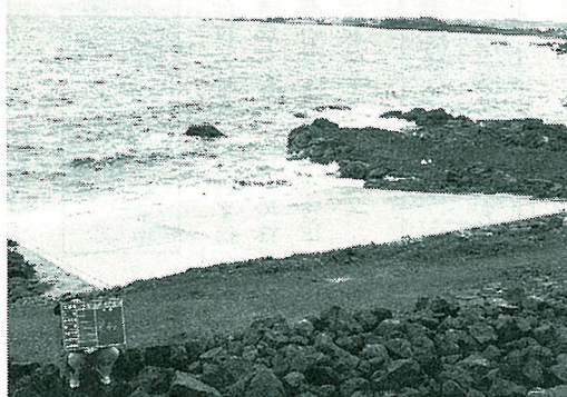
日出町船揚場整備工事 61年11月30日完成
