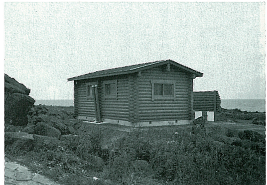
沓形岬公園便所新設工事 62年 6 月 30日完成
