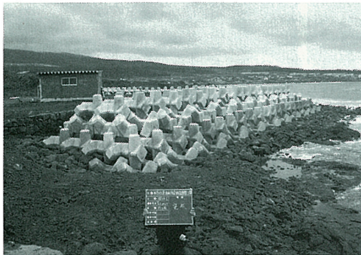
沓形港海岸保全整備工事 62年10月30日完成
