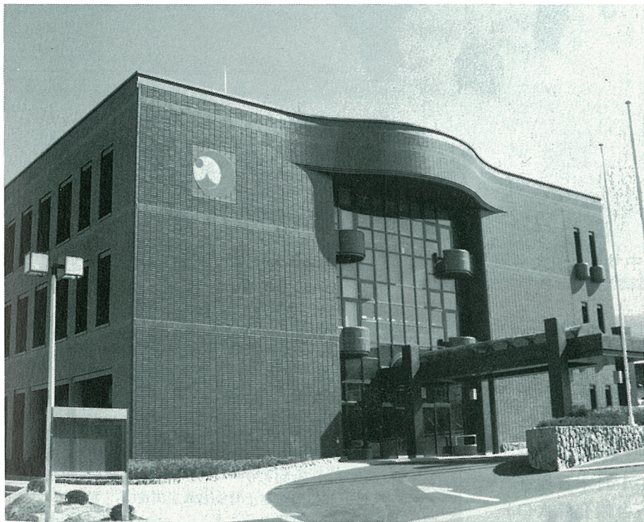
利尻町役場庁舎新築工事 62年 9 月 9 日完成
