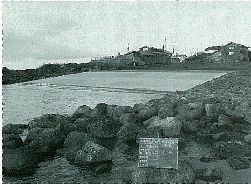
富士見町第3船揚場整備工事 63年12月2日完成
