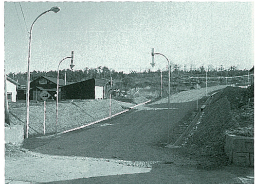
種富16号線特殊改良1種工事 63年11月28日完成
