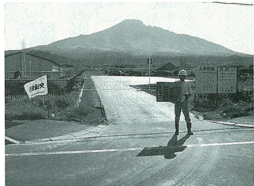
経営林道神居線 元年 8 月 2 日完成
