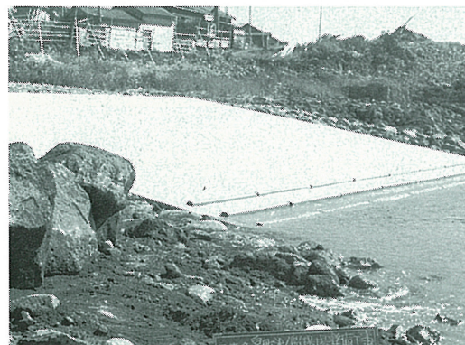
泉町第 1 船揚場整備工事 元年 8 月 4 日完成
