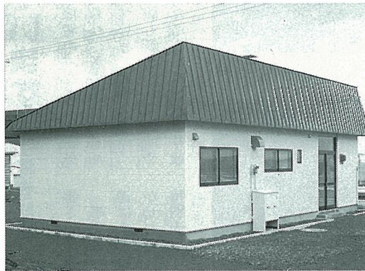
教員住宅新築工事 元年 11 月 25 日完成
