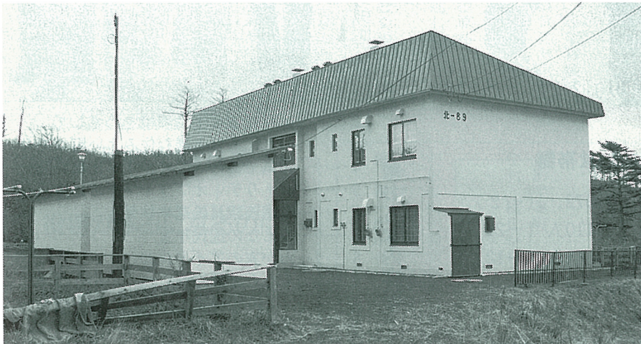
公営住宅新築工事 元年11月10日完成
