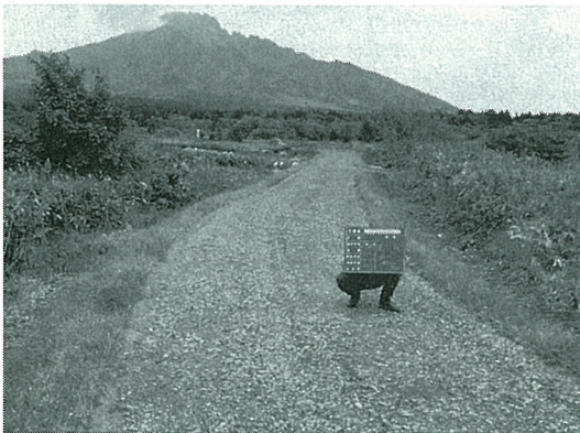
経営林道神居線開設工事 平成2年9月29日完成
