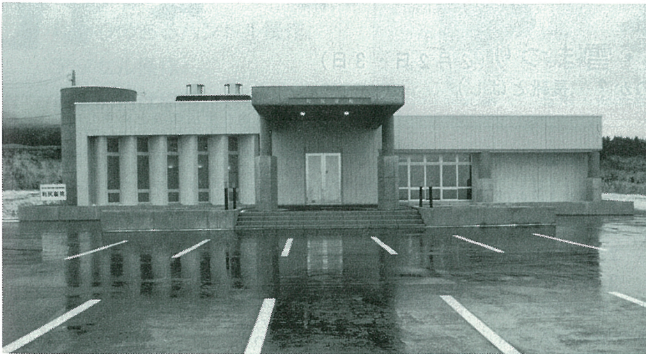
利尻町葬祭場新築工事 平成2年11月16日完成
