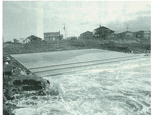
新湊第5船揚場整備工事 平成3年11月27日完成
