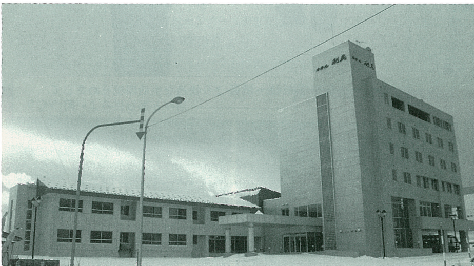
利尻町宿泊施設建設工事 平成3年10月1日
