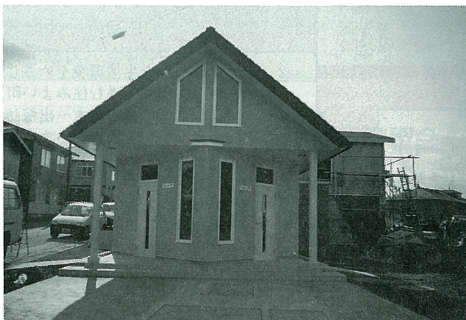
さわやかトイレ建設工事 平成4年10月15日完成
