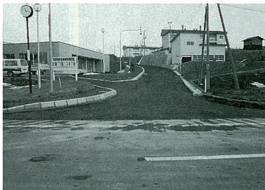
仙法志市街12号線特殊改良1種工事 平成4年12月8日完成
