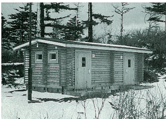
森林公園整備工事(トイレ) 平成4年11月10日完成
