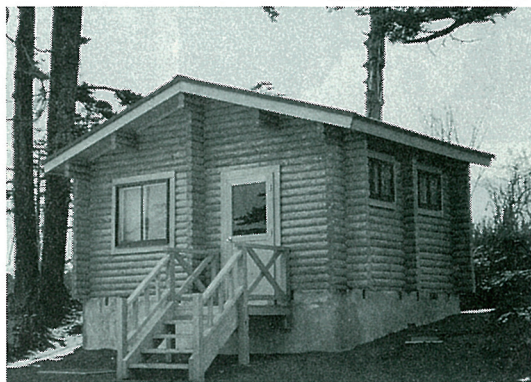
森林公園整備工事(管理棟) 平成4年11月10日完成
