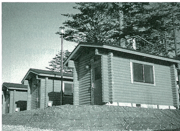
◀利尻町森林公園整備工事 (バンガロー) 平成5年11月10日完成
