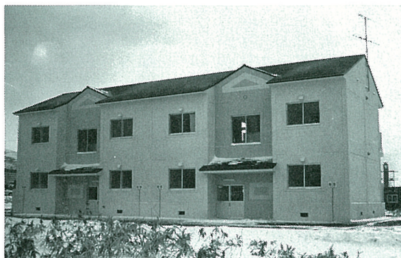
利尻町特別養護老人ホーム▶ 職員住宅新築工事 平成5年12月10日完成
