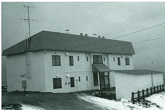
◀利尻町公営住宅新築工事 平成5年12月23日完成
