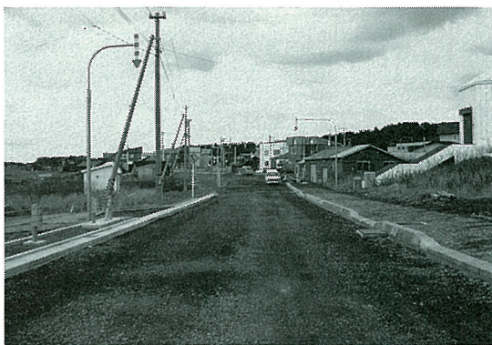
神居2号線道路改良工事 平成5年11月4日完成
