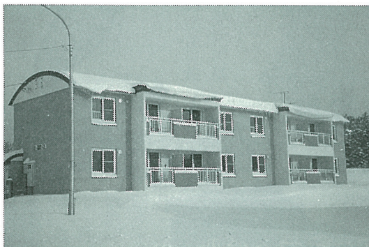
▶特定公共賃貸住宅新築工事 若者単身者向 (神居団地 1棟8戸) 平成7年12月21日完成
