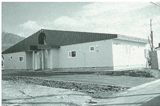
◀特定公共賃貸住宅新築工事 (新湊団地 1棟2戸) 平成7年10月20日完成
