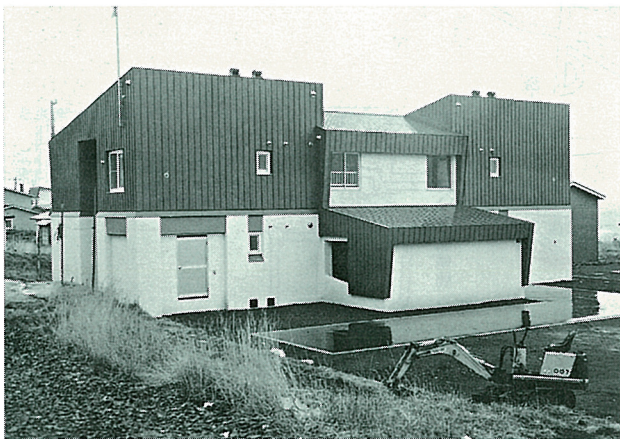
公営住宅建設工事 (仙法志団地)
