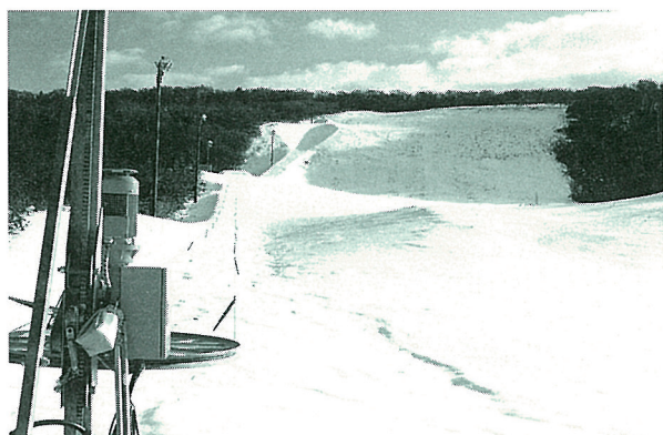
◀天望山スキー場整備工事 H 9 .11.25 完成
