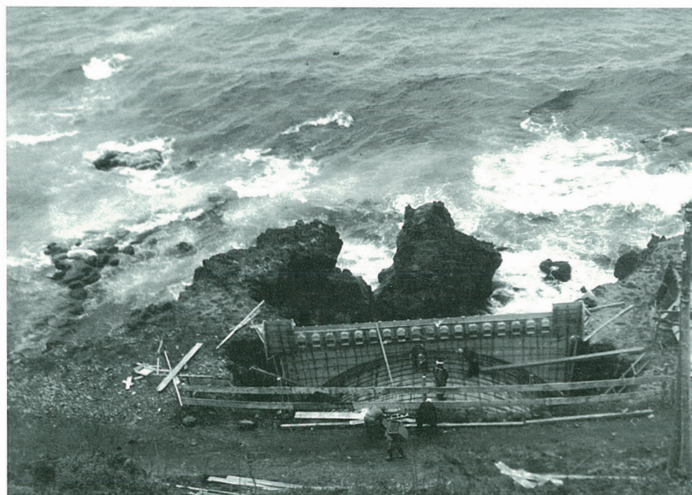
久連海岸道路拡幅のアーチ型橋工事 昭和26年
