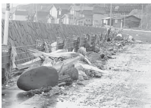
▲高潮による被害（久連地区）
