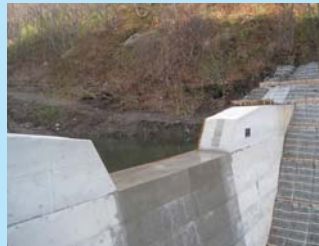
写真：完成した治山ダム
