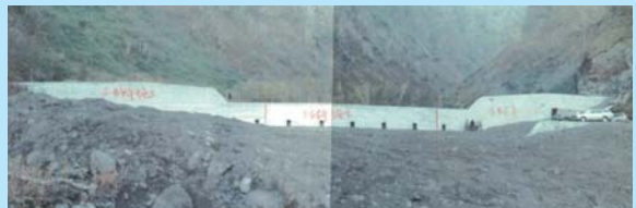
写真：鬼脇地区昭和44～46年設置治山ダム
