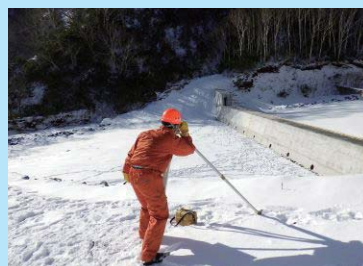
完成した治山ダムを確認する細野
