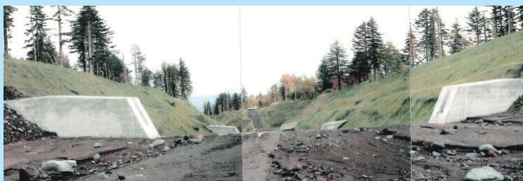
写真：H15アフトロマナイ川の低ダム群
